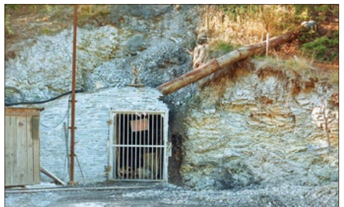
„Neuer Stollen 1990“ - heutiger Eingang für den Besucherrundgang
