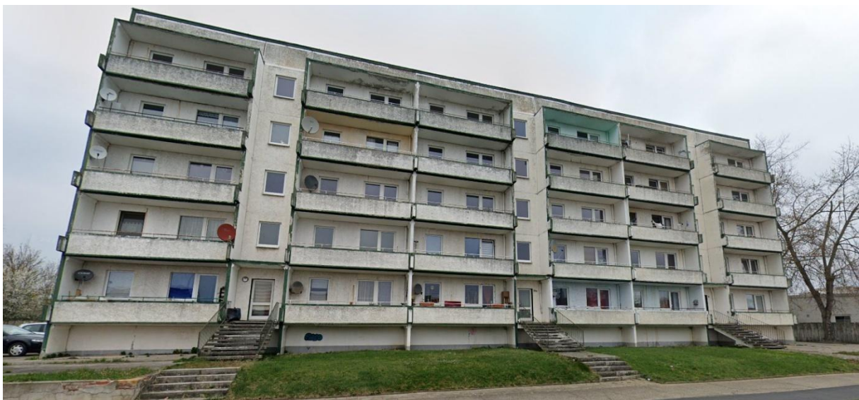
Abbildung 17: Freistehendes Mehrfamilienhaus (Baujahr ca. 1970) in Plattenbauweise
