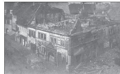
Höhnsches Haus in der Saalstraße nach dem Brand. Foto 1911. (Quelle: Bildarchiv Stadtmuseum)
