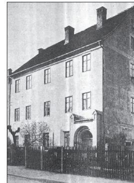
Ehemalige Fronfeste an der Alten Freiheit, später Krankenhaus. Foto um 1900. (Quelle: Bildarchiv Stadtmuseum)
