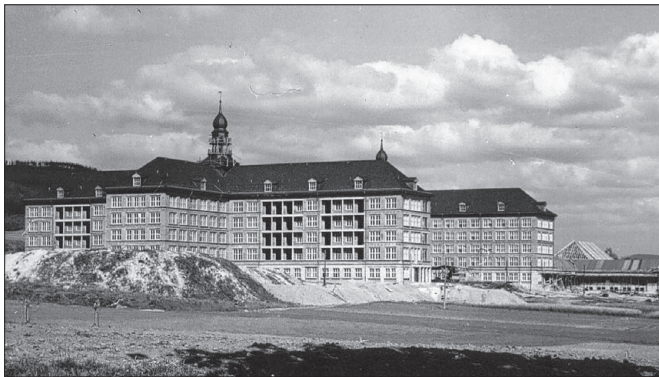
Bau des Agricola-Krankenhauses. Foto, um 1959. (Quelle: Bildarchiv Stadtmuseum)
