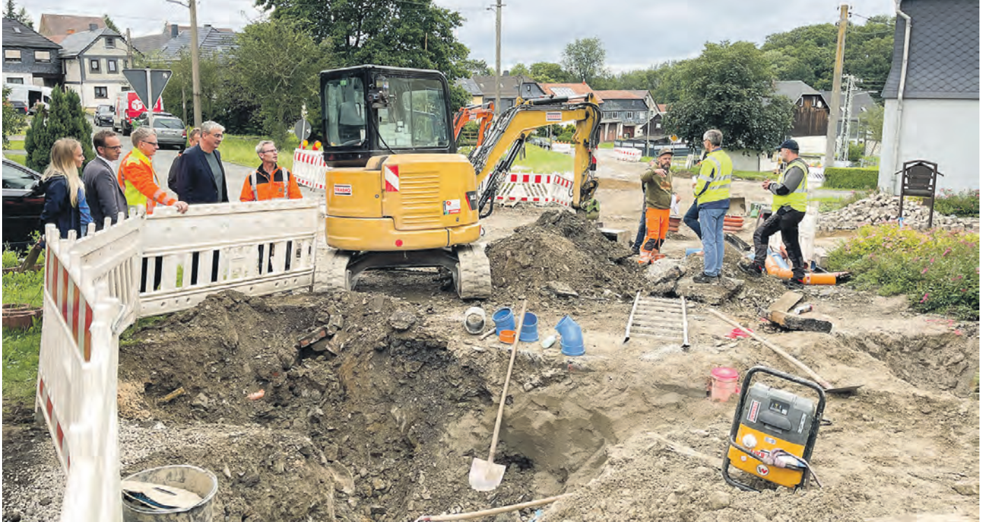
Aktuell laufen im Landkreis millionenschwere Bauarbeiten an Kreisstraßen wie hier in Dorfilm. Hier bauen ZWA, TEN, Gemeinde und Landkreis gemeinsam Abwasser, Trinkwasser, Stromversorgung, Breitband, eine barrierefreie Bushaltestelle und die Kreisstraße in der Ortsdurchfahrt. (Foto: Peter Lahamm)
