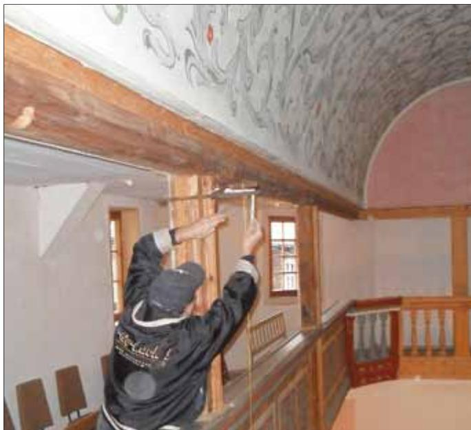
Die erste Baumaßnahme, die den Druck der auseinanderbewegenden Gebäudeseiten stoppte und stabilisierte, sind zwei Spanneisen. Sie verbinden die Gebäudeteile der Nord- und der Südseite.
