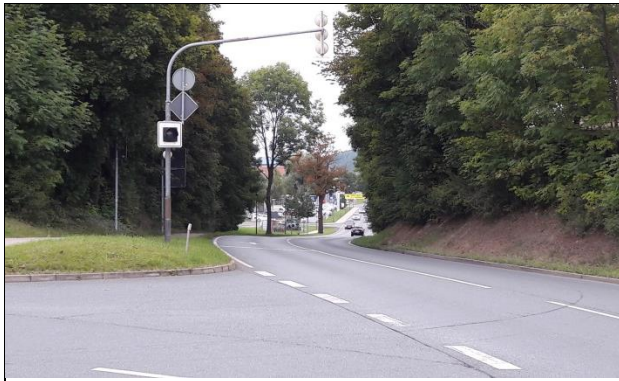
Fehlende Linksabbiegespur auf der B 281 in die Straße Fingerstein
