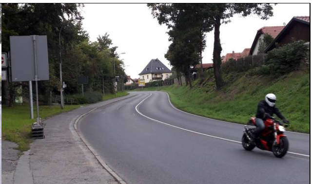
Fehlende Führung der Radfahrer in der Steigungsstrecke
