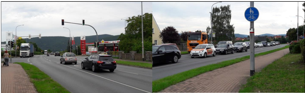
Überlasteter LSA-geregelter Knoten Mittlerer Watzenbach mit erhöhter Unfallgefahr (Vorfahrts-, Abbiege- und Auffahrunfälle).
