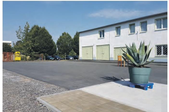
folgten durch die STRABAG AG Rudolstadt auf einer Fläche von 30 x 20 Metern Erdarbeiten, Entwässerung (Kastenrinne) und Belagarbeiten.
