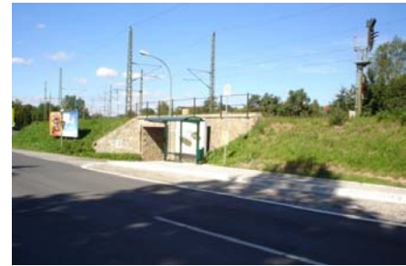
Errichtung Bushaltestelle Köditz Quelle: Bauhof der Stadt Saalfeld
