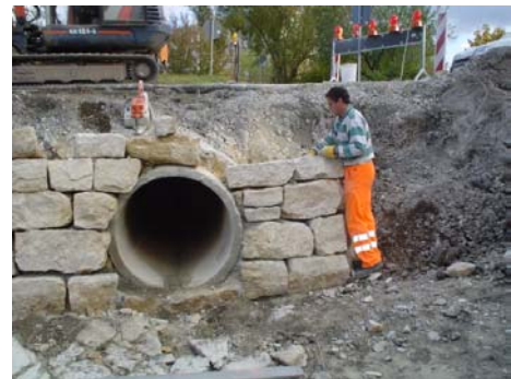
Kanalbauarbeiten Quelle: Bauhof der Stadt Saalfeld
