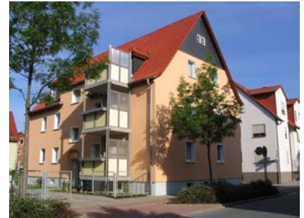
Pestalozzistraße 17 Quelle: WOBAG Saalfeld/Saale mbH
