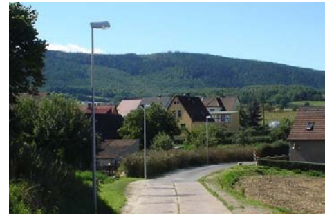
Straßenbeleuchtungsneubau Crösten Quelle: Bauhof der Stadt Saalfeld
