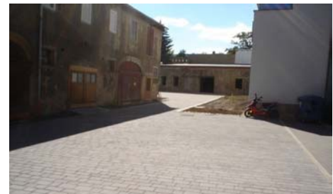
Pflasterung Innenhof Markt 6 Quelle: Bauhof der Stadt Saalfeld
