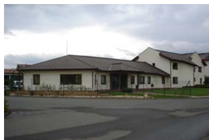
Verwaltungsgebäude Bauhof der Stadt Saalfeld
