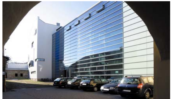
Bürger- und Behördenhaus Markt 6 - Südostfassade Quelle: WOBAG Saalfeld/Saale mbH
