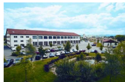
Verwaltungsgebäude Stadtwerke Saalfeld GmbH
