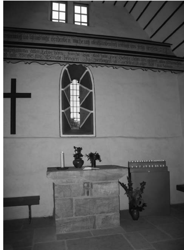
Die sanierte Martinskapelle, Blick zum Altar. Die Ausmalung des darüber liegenden Ostfensters erfolgte nach historischen Befunden.
