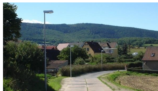
Straßenbeleuchtungsneubau Crösten Quelle: Bauhof der Stadt Saalfeld
