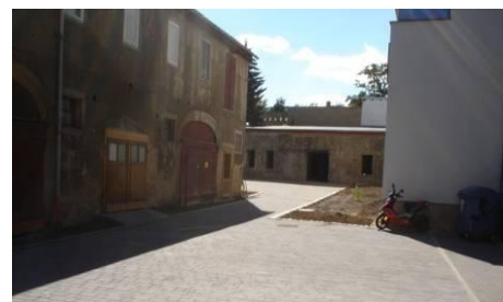
Pflasterung Innenhof Markt 6 Quelle: Bauhof der Stadt Saalfeld
