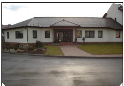
Verwaltungsgebäude Bauhof der Stadt Saalfeld
