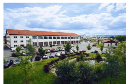
Verwaltungsgebäude Stadtwerke Saalfeld GmbH
