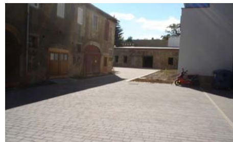
Pflasterung Innenhof Markt 6
