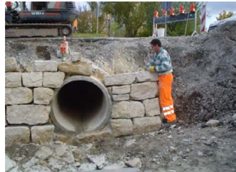
Kanalbauarbeiten Quelle: Bauhof der Stadt Saalfeld
