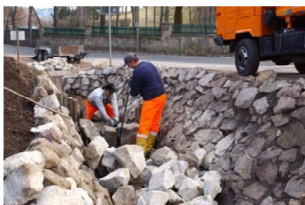
Baustelle Adrianstal Bauhof der Stadt Saalfeld
