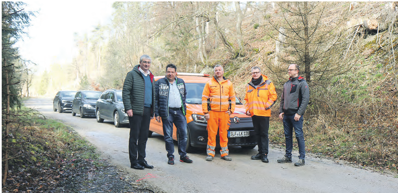
Zum Baubeginn in der Meernacher Straße in Gräfenenthal wurde unter anderem die Ausweichstrecke ertüchtigt, zusätzliche Ausweichstellen geschaffen und Warnbaken aufgestellt. Zur Verbesserung der Sicherheit wurde zudem ein provisorischer Fußweg geschaffen, damit Anwohner nicht durch die Engstelle an der Baustelle laufen müssen. Im Bild (von links): Landrat Marko Wolfram, Bauleiter Michael Blechschmidt und Polier Stefan Rosenfeld von der August Dohrmann GmbH, Tiefbau-Sachgebietsleiter Marko Schoenheyd und Stadtratsmitglied Marcel Kuhnen.
