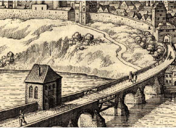
Saalebrücke mit der 1637 gebrochenen Lücke, notdürftig ausgebessert. Ausschnitt aus einem Kupferstich v. Matthäus Merian 1650. (Quelle: Bildarchiv Stadtmuseum)
