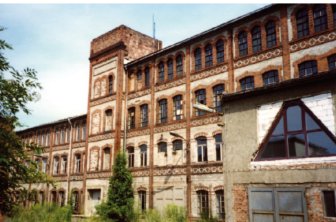
Werksgebäude der Waschmaschinenfabrik Adam Schmidt (erbaut 1892), 2003. (Quelle: Bildarchiv Stadtmuseum)
